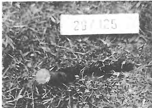
Bild 16: Einschneiden eines Schrägzugankers in den Boden.
