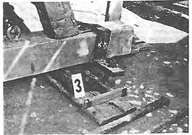
Bild 5: Verankerung eines Kettenfliegers durch 2 Stabanker und einen Stahlbügel.
