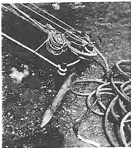
Bild 4: Hauptmastverankerung eines Zirkuszeltes durch 3 Stabanker.
